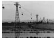
1950年代に行なわれていた「架空索道客土」の様子 (写真提供：美瑛市)
